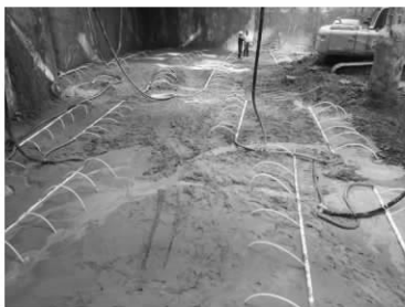
图 1 基底轻型井点降水后效果
