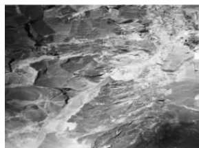
图1 隧洞内围岩变形
