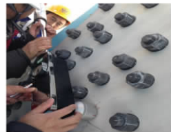
图 5 高强螺栓划线检查及终拧扭矩检查
