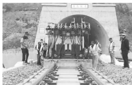
图 4 聚氨酯固化道床浇注作业
