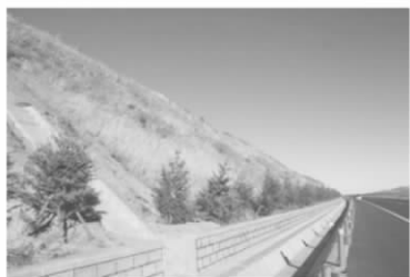
图 5 风积砂边坡绿化覆盖 2 年后效果
