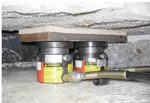
图4 桥梁顶升装置
