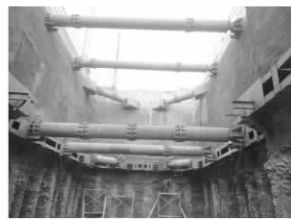
图 2 世纪大道站围护结构现场施工照片
