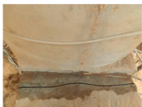
图3 第1道中横梁顶面横向裂缝
