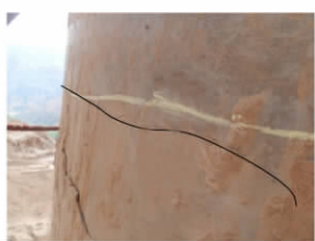
图2 墩柱环向裂缝
