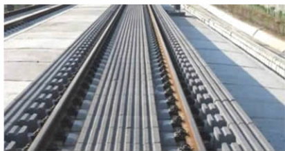
图4 无砟轨道吸声板铺设现场
